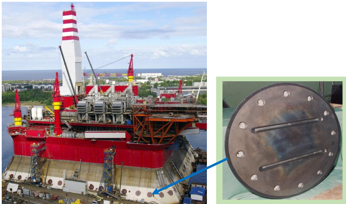
Рисунок 6.2 Аноды типа АКЛ-2МУ, установленные на бортовой поверхности кессона МЛСП «Приразломная»
