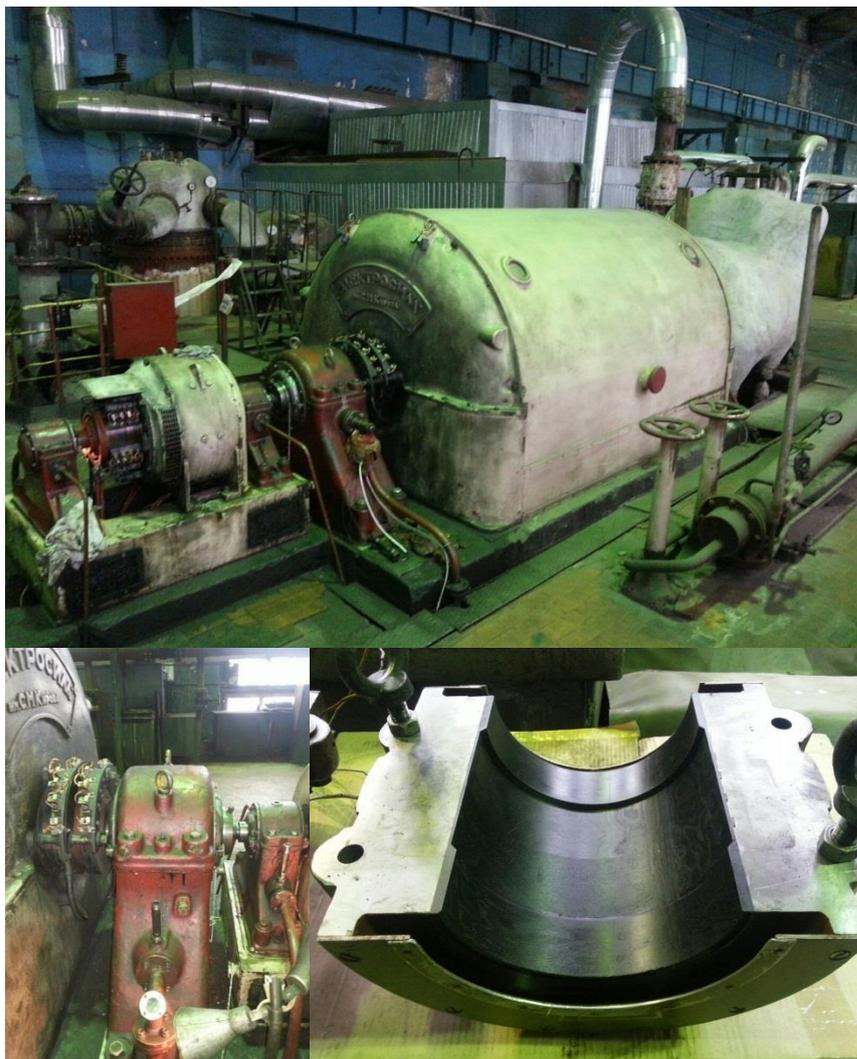
Рисунок 7.4. Турбогенератор АР-6 производства ОАО «КТЗ» и опора скольжения из углепластика УПФС.
